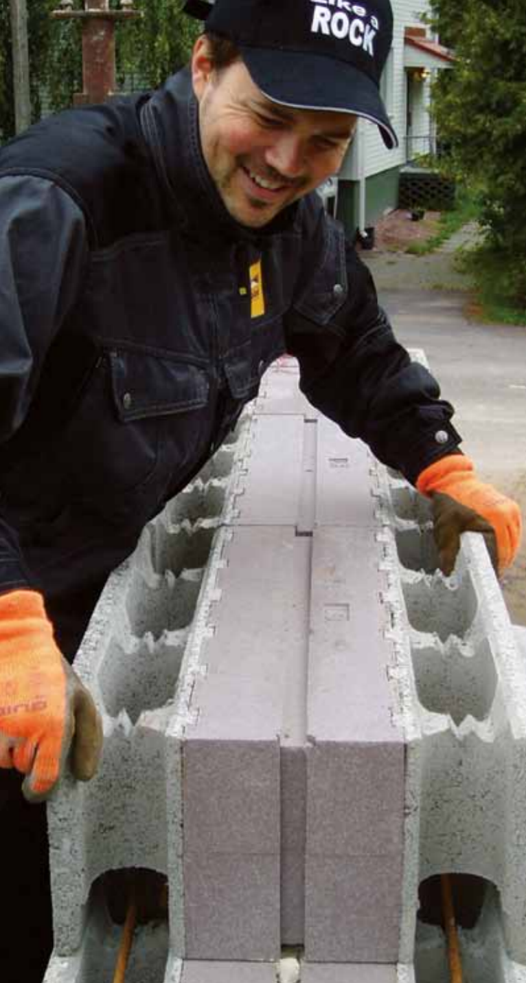
Laotavad soojustatud plokkid muudavad ehitamise kiireks ja lihtsaks. Kivide ülaseravad on teemantlihvitud õigesse mõõtu. See muudab ka kõrgemate konstruktsioonide ladumise lihtsaks.
