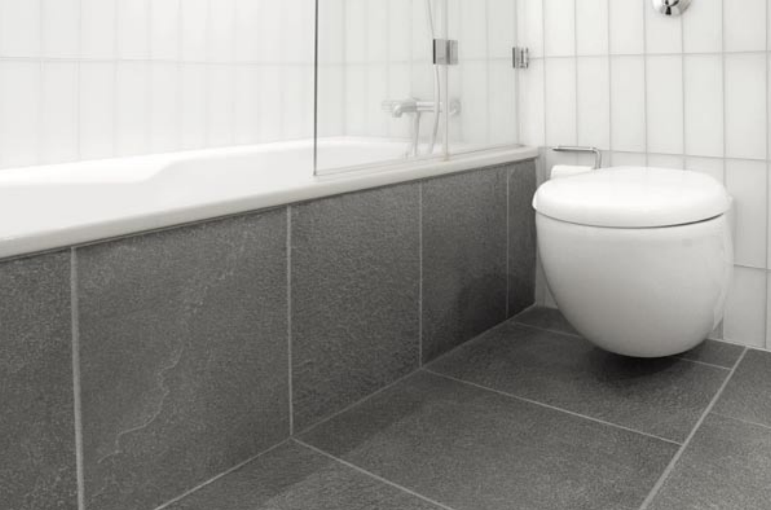
Altaskifer: Flis med natur overflate på gulv og innbygging av badekar
