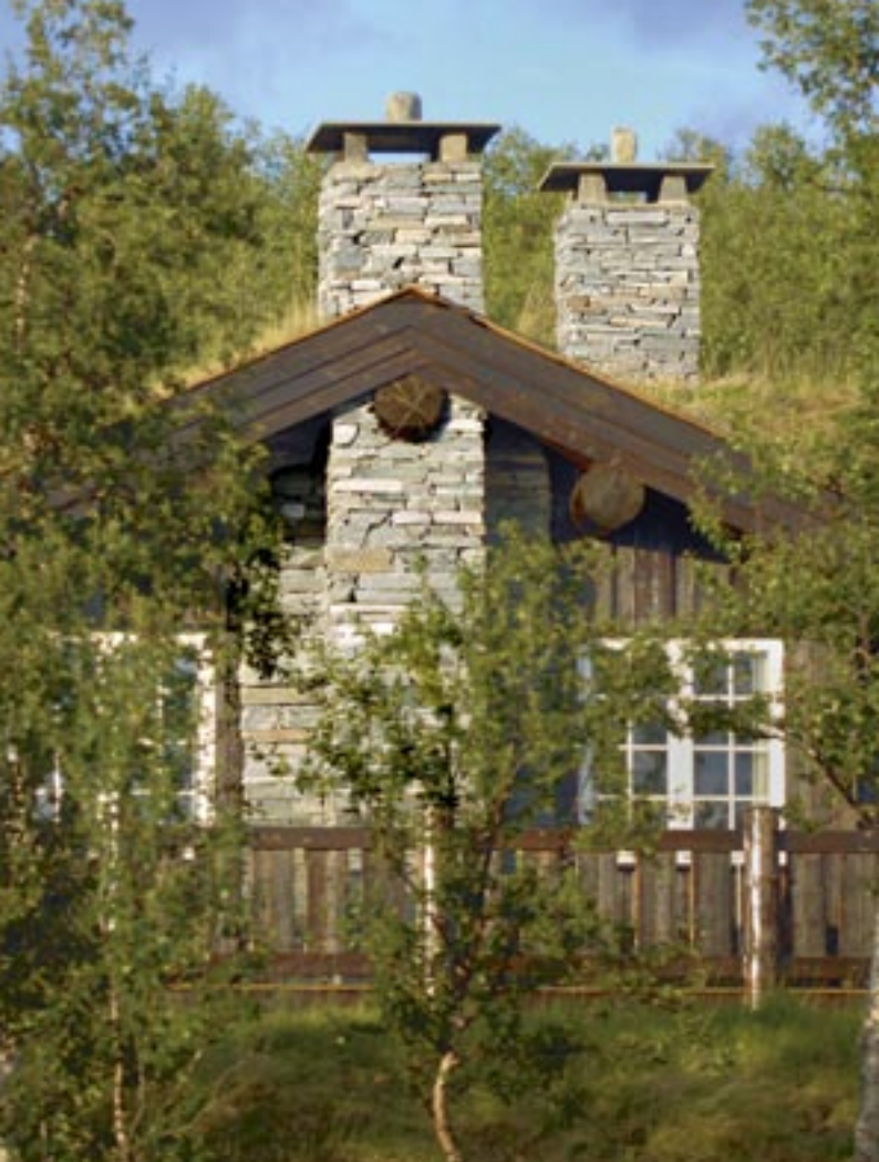
Oppdalskifer: Piper i tørmur med murstein 5-20 cm og pipeheller
