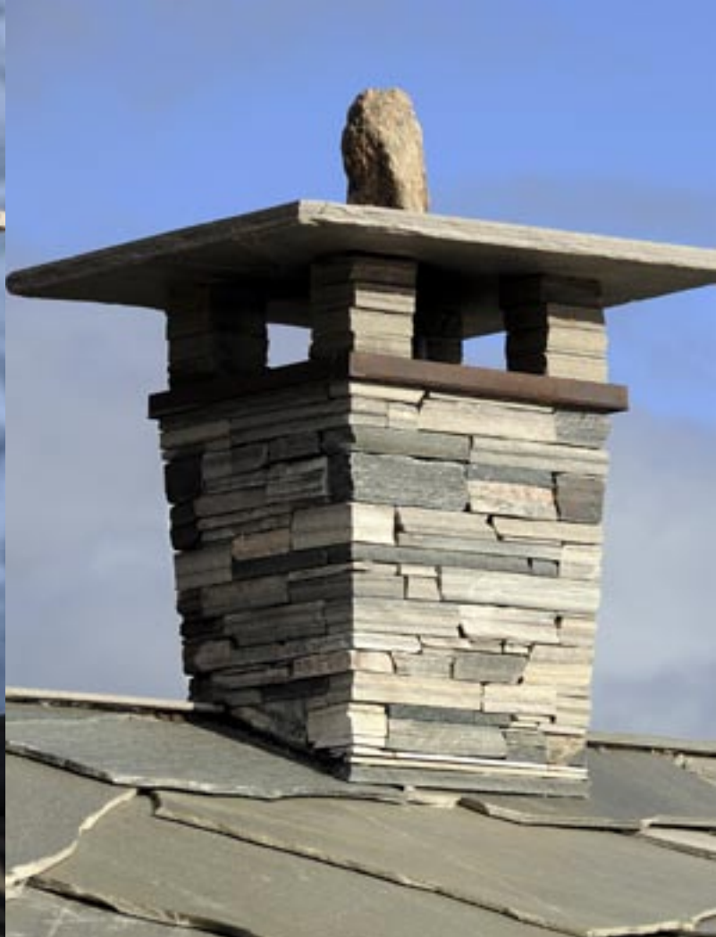
Oppdalskifer: Pipe i tørrmur med pipehelle og bruddheller på taket
