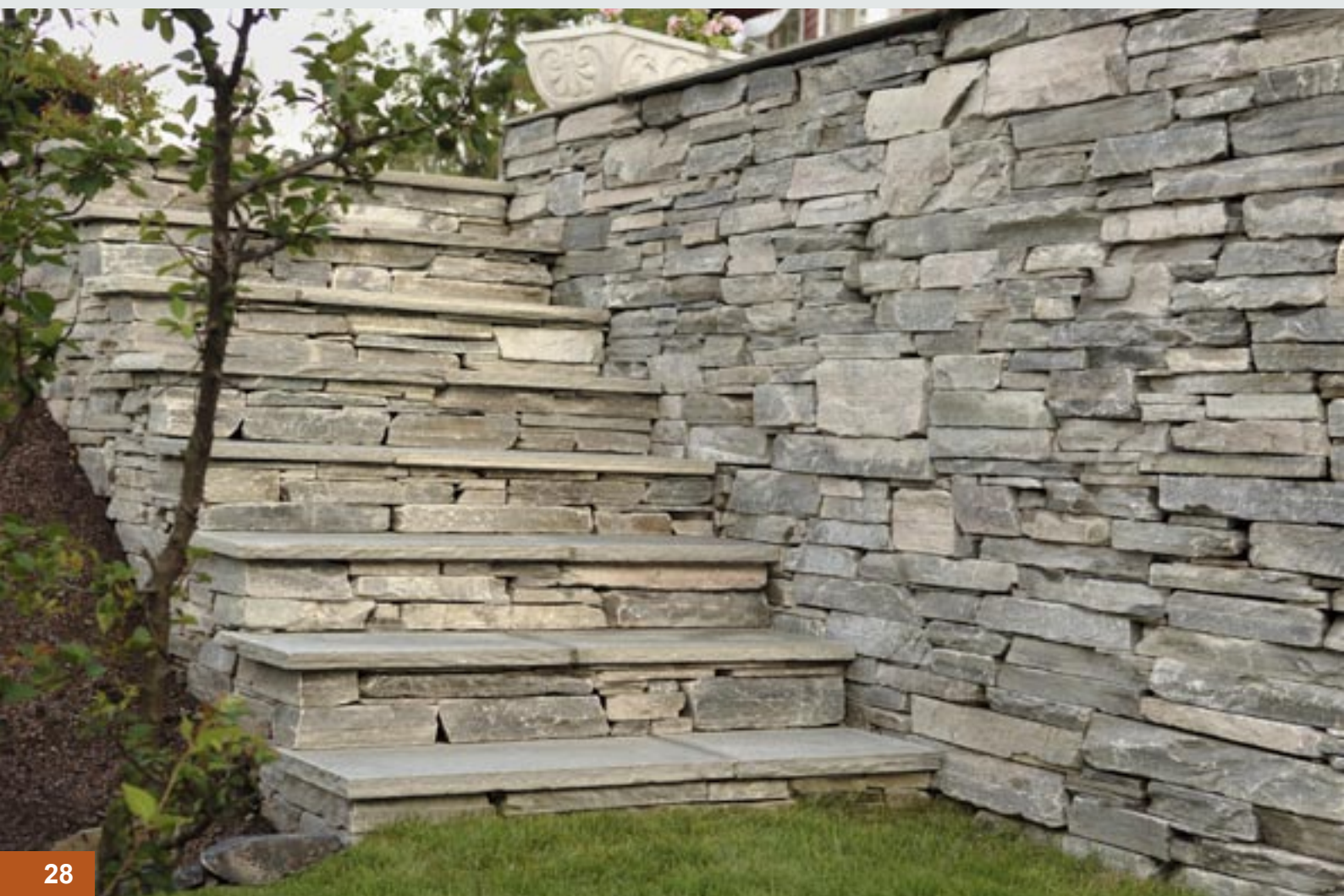
Oppdalskifer: Trappetrinn med hogd kant og murstein (15-30 cm) som tørrmur og opptrinn
