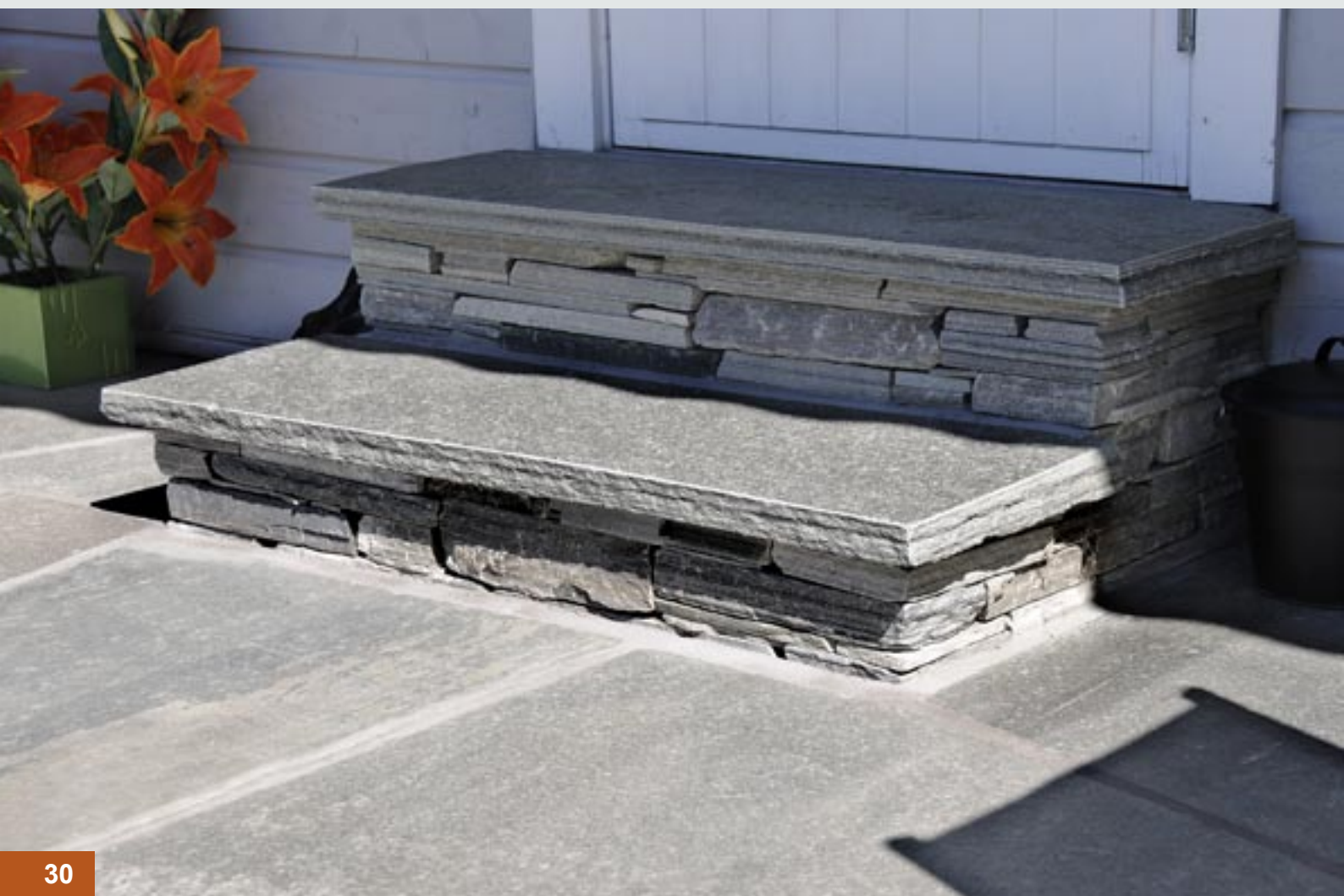
Oppdalskifer: Trappetrinn med hogd kant og opptrinn med murstein (5-20 cm) som tørmur
