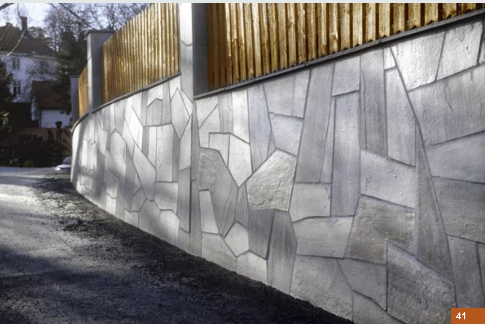
Oppdalskifer: Forblending med mellomstore og store bruddheller
