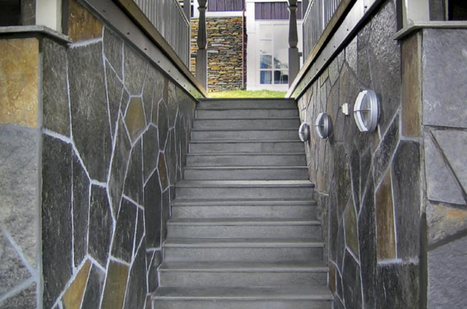
Ottaskifer: Bruddheller til forblending. Oppdalskifer: Opptrinn og inntrinn med hogd kant i trapp
