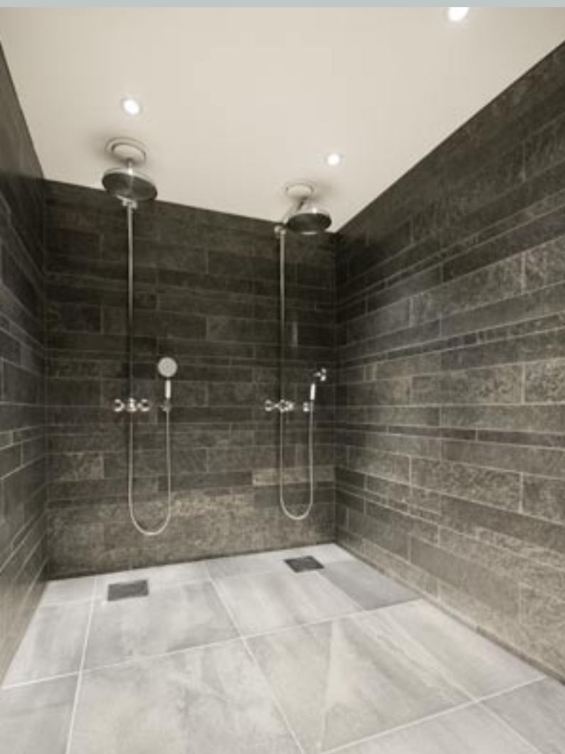
Ottaskifer: Vegger m/slipt flis. Oppdalskifer: Slipt gulvflis
