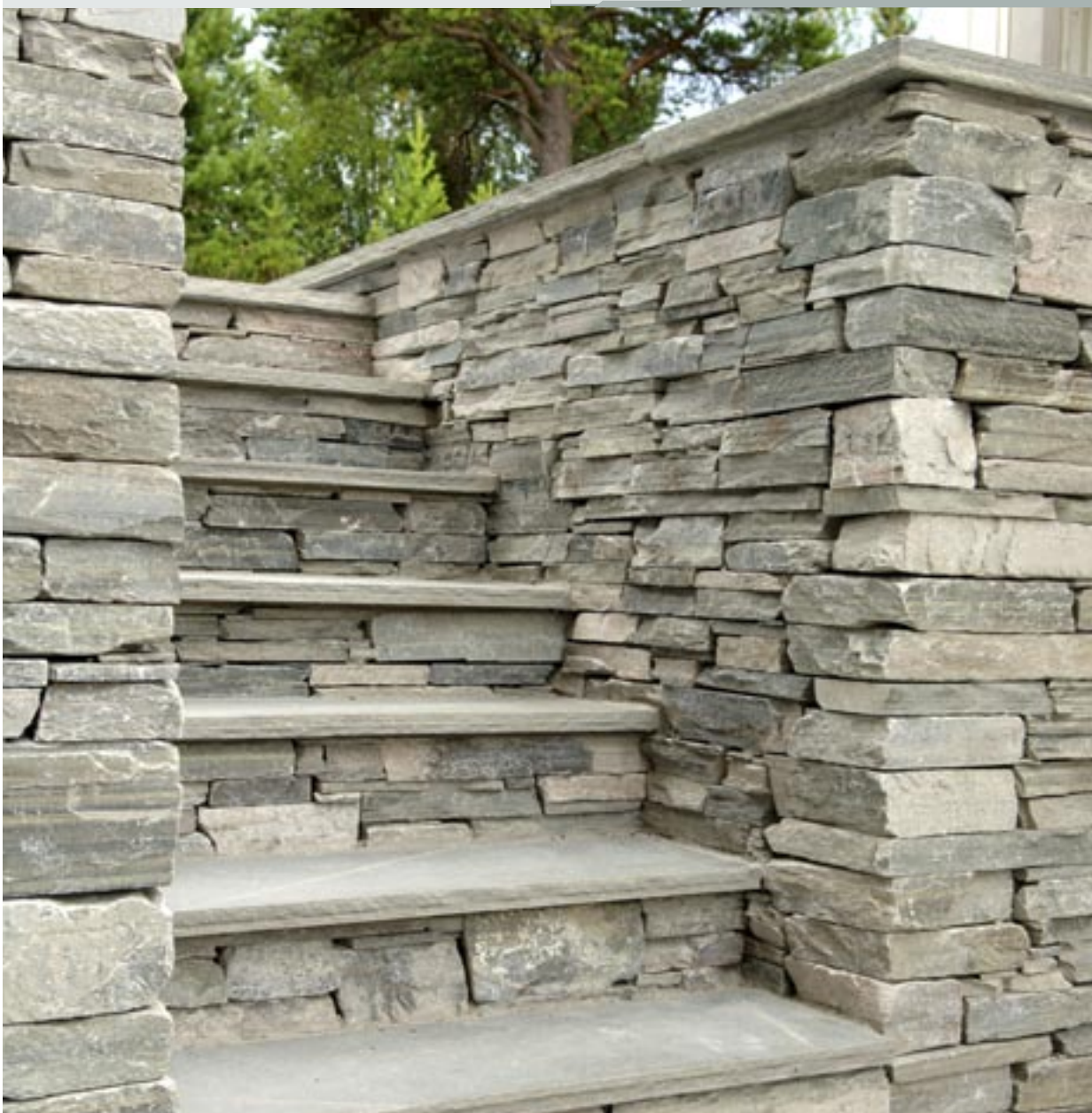
Oppdalskifer: Trappetrinn og murstein som tørrmurer og opptrinn. Avdekning med hogd kant på toppen av mur
