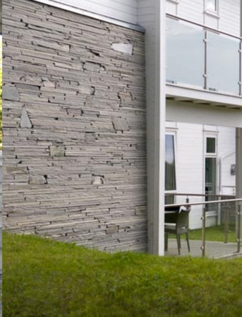
Oppdalskifer: Fasade forblendet med hogd murstein (5-15 cm)
