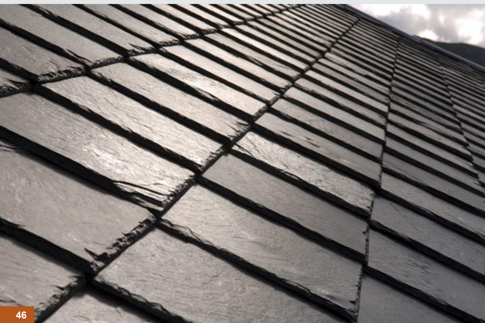
Altaskifer: Tak med klipt firkantstein
