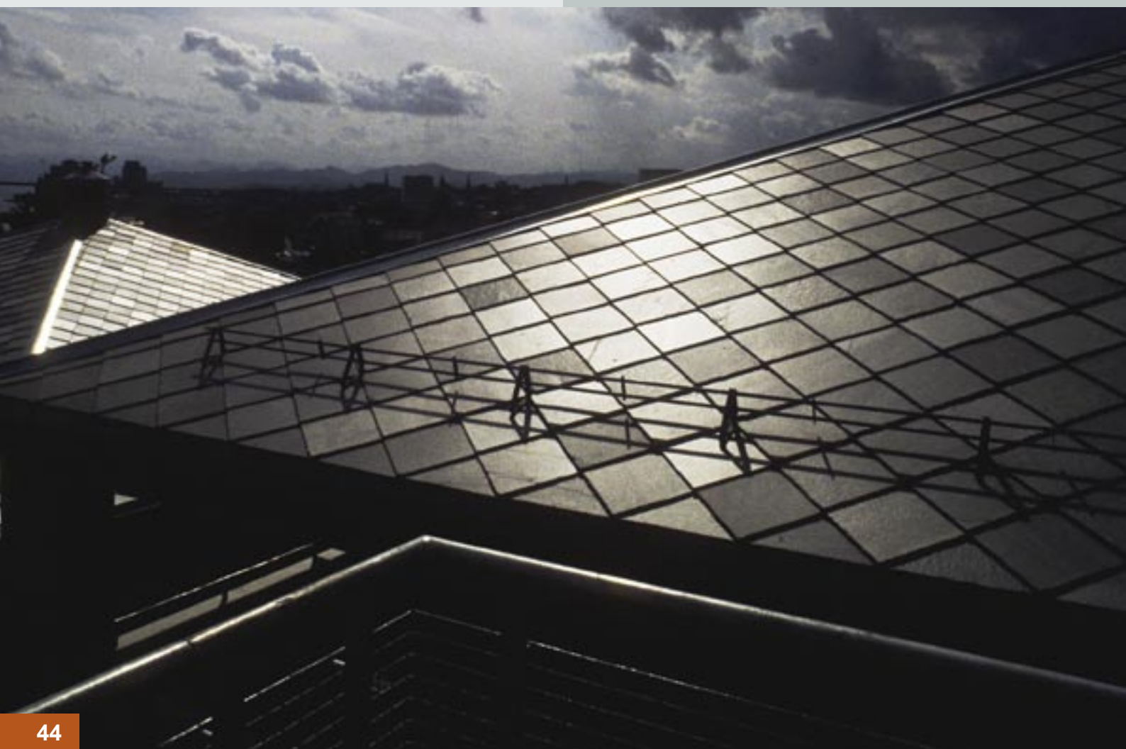
Altaskifer: Tak med klipt firkantstein
