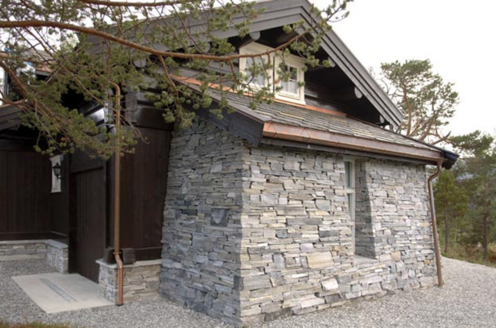
Oppdalskifer: Murstein (nederst 15-30 cm, øverst 5-20 cm) til fasade i tørmur
