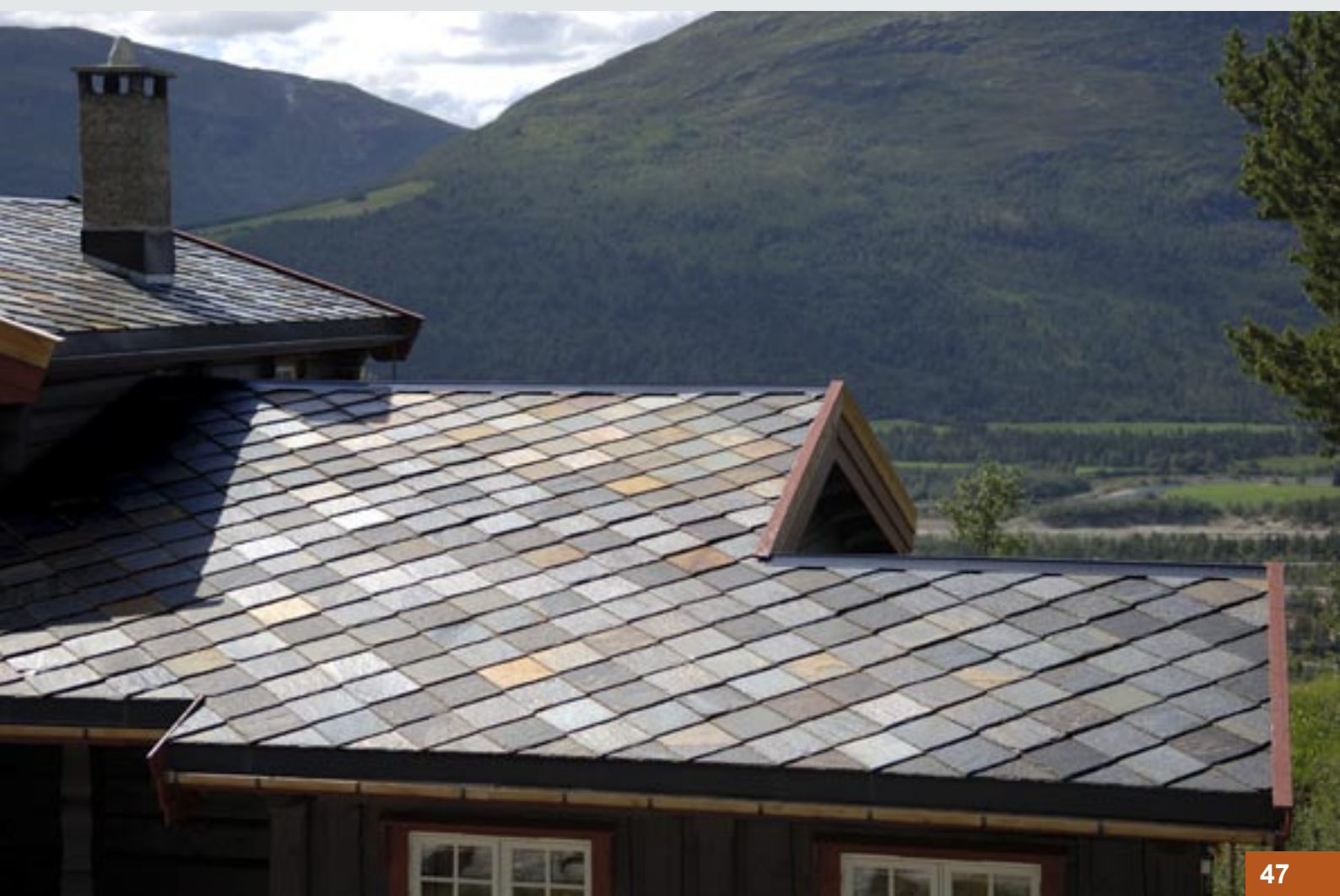
Ottaskifer: Tak med klipt firkantstein
