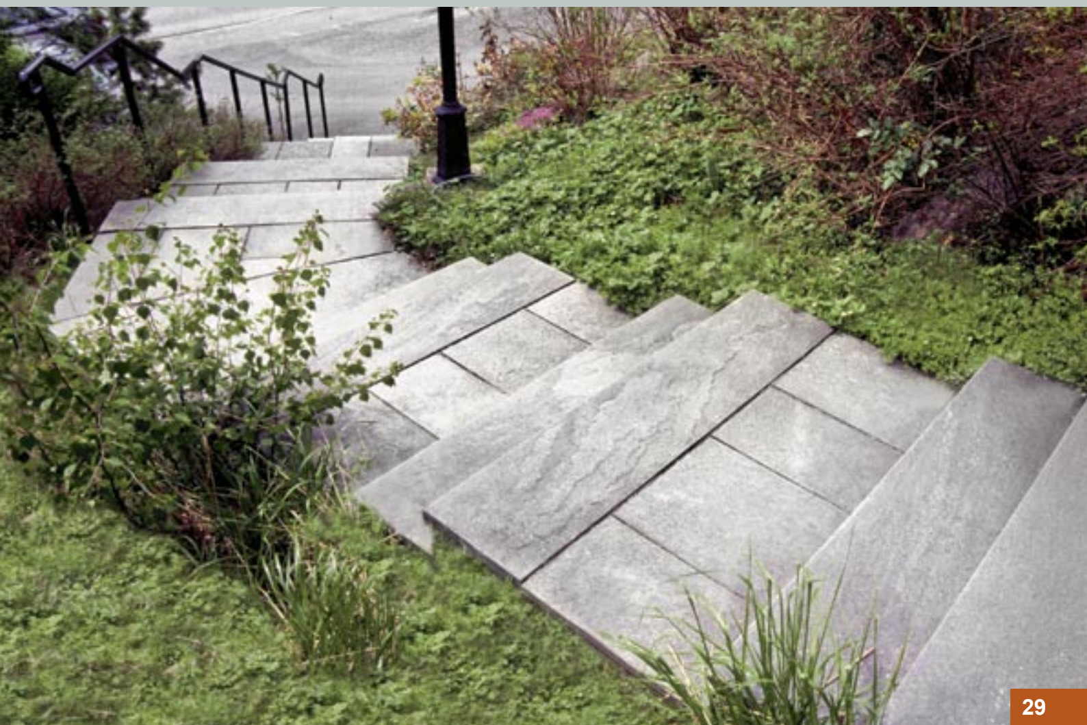
Oppdalskifer: Trappetrinn og reposheller med hogd kant
