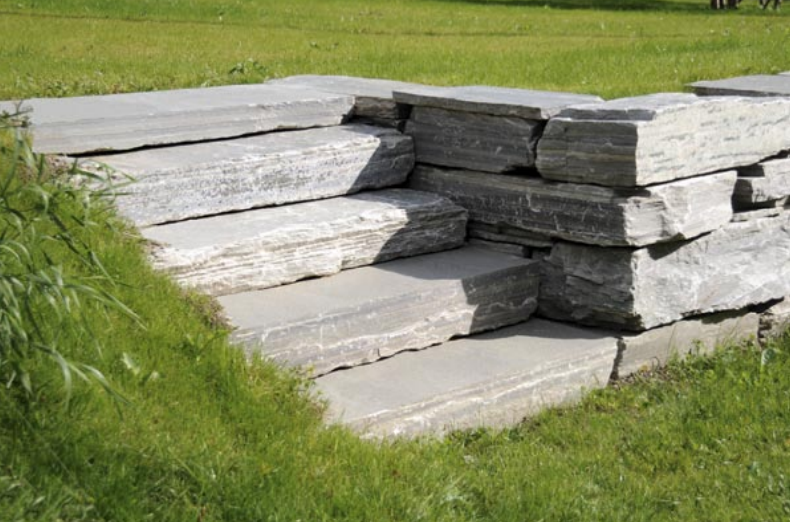
Oppdalskifer: Massive terrengtrinn og maskinstein (40-70 cm) som tørmur
