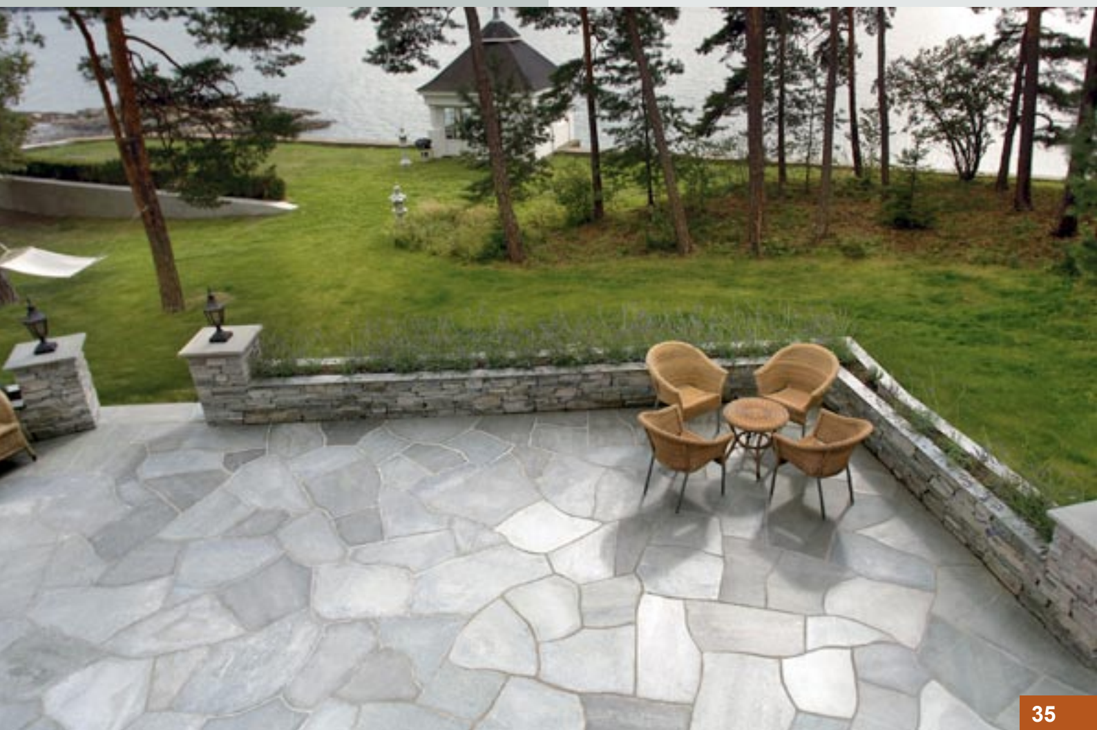
Oppdalskifer: Uteplass med mellomstore bruddheller og murstein i tørrmurer. Avdekningsheller på toppen av murer og stolper
