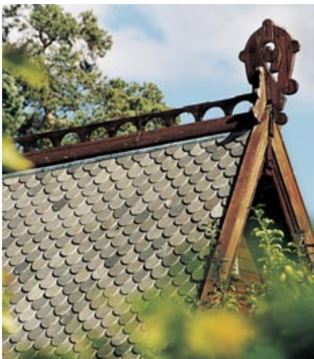
Altaskifer: Tak med klipt lappstein
