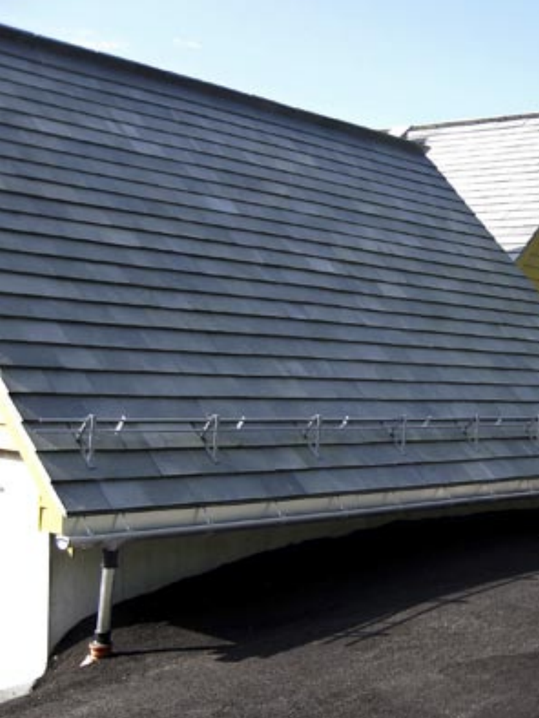
Altaskifer: Tak med heller i fallende lengder og sagede kanter
