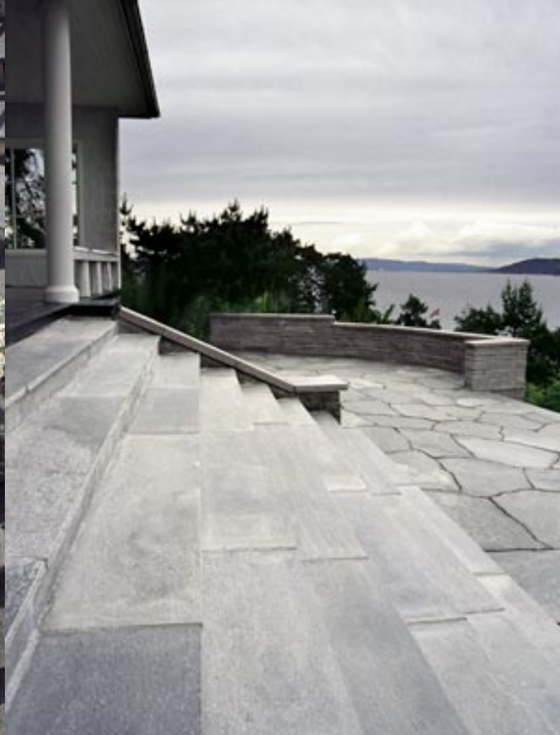
Oppdalskifer: Trappetrinn med hogd kant og bruddheller på terrasse
