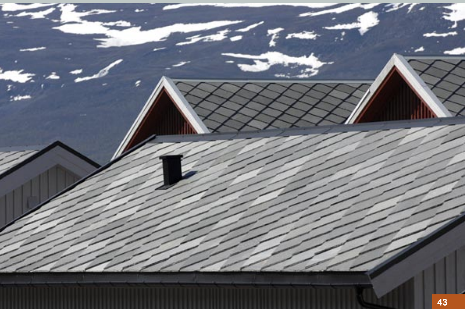
Altaskifer: Tak med klipt firkantstein
