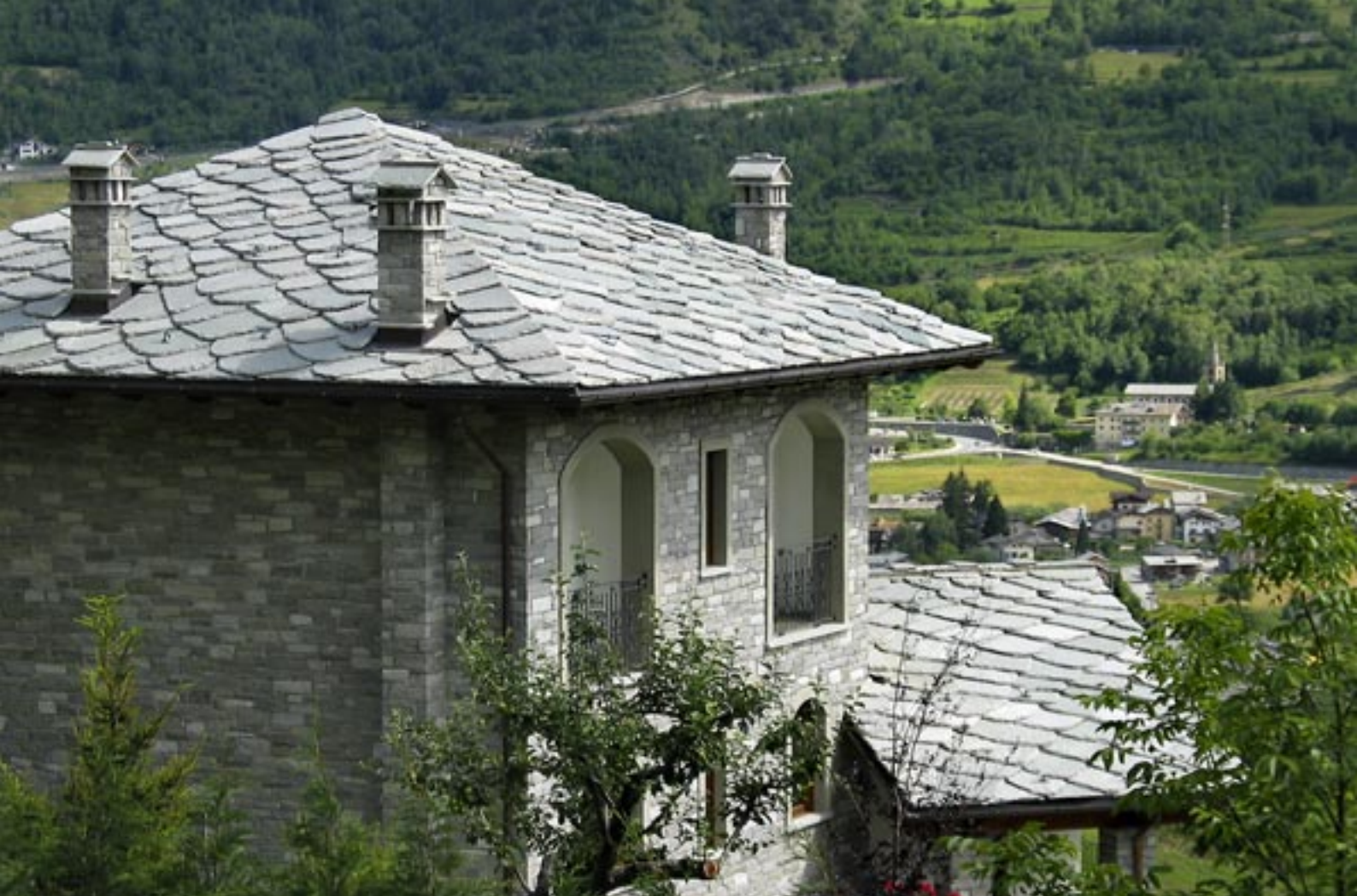
Altaskifer: Tak med bruddheller i Aostadalen (Italia)
