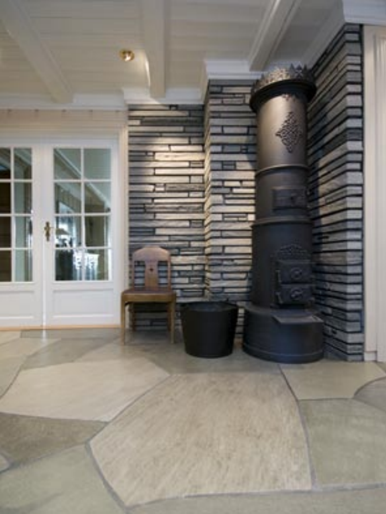
Oppdalskifer: Bruddheller (flisemner) og hogd murstein
