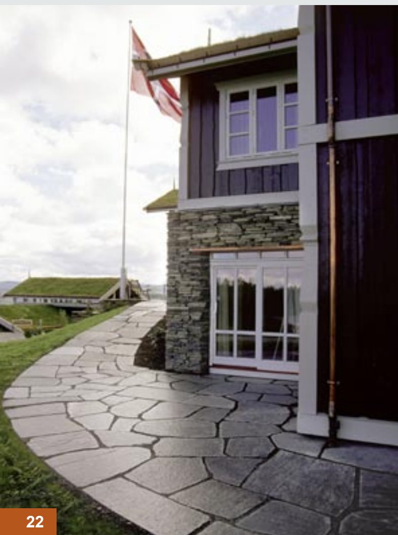
Ottaskifer: Bruddheller lagt i sand og tørrmur i fasade
