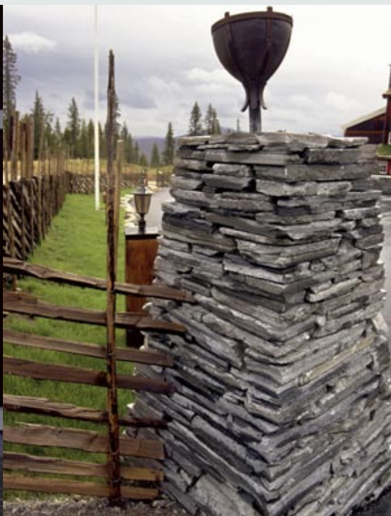
Oppdalskifer: Grindstolpe i murstein med hogd- og naturkant
