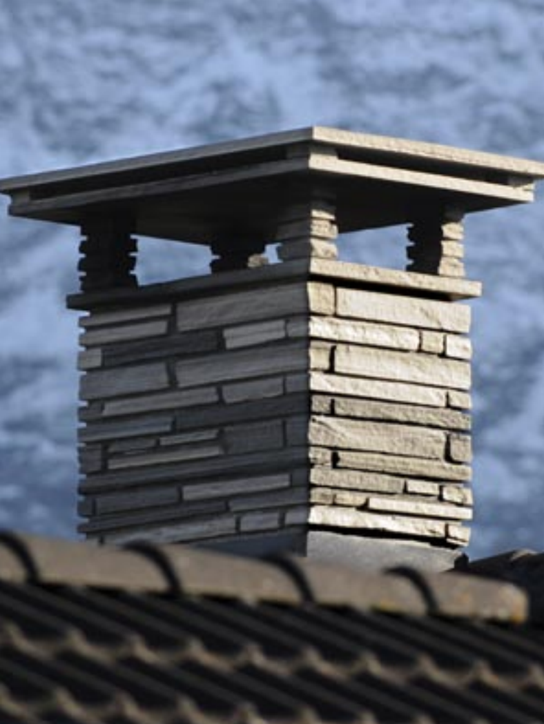
Oppdalskifer: Pipe med hogd murstein og doble pipeheller
