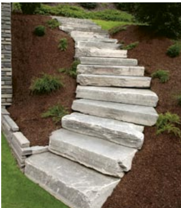
Oppdalskifer: Massive terrengtrinn
