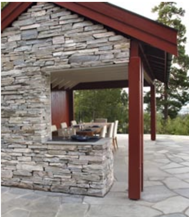
Oppdalskifer: Murstein 5-20 cm til tørmur/bruddheller
