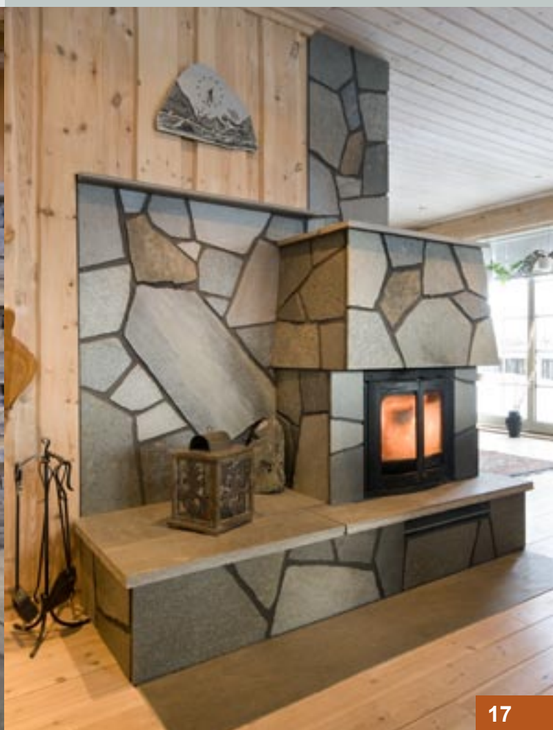
Oppdalskifer: Peis plastret (forblendet) med bruddheller
