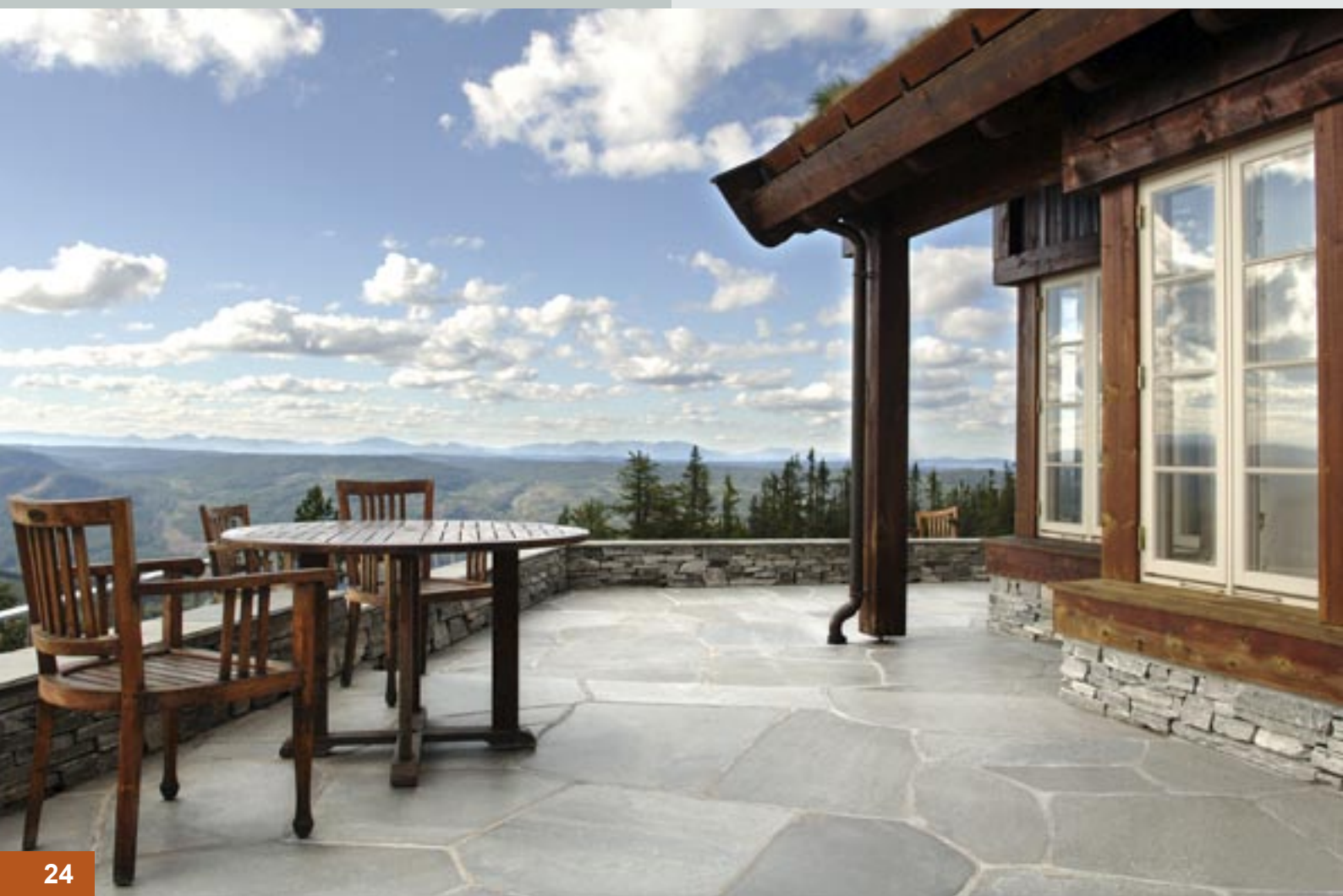
Oppdalskifer: Bruddheller på terrasse og murstein (5-20 cm) til tørmur
