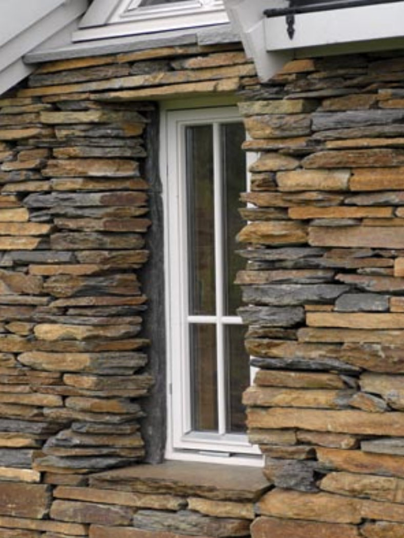
Ottaskifer: Murstein til tørrmur
