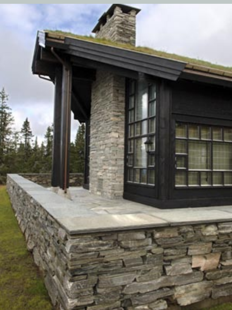
Oppdalskifer: Tørmur med avdekning og pipe med pipehelle
