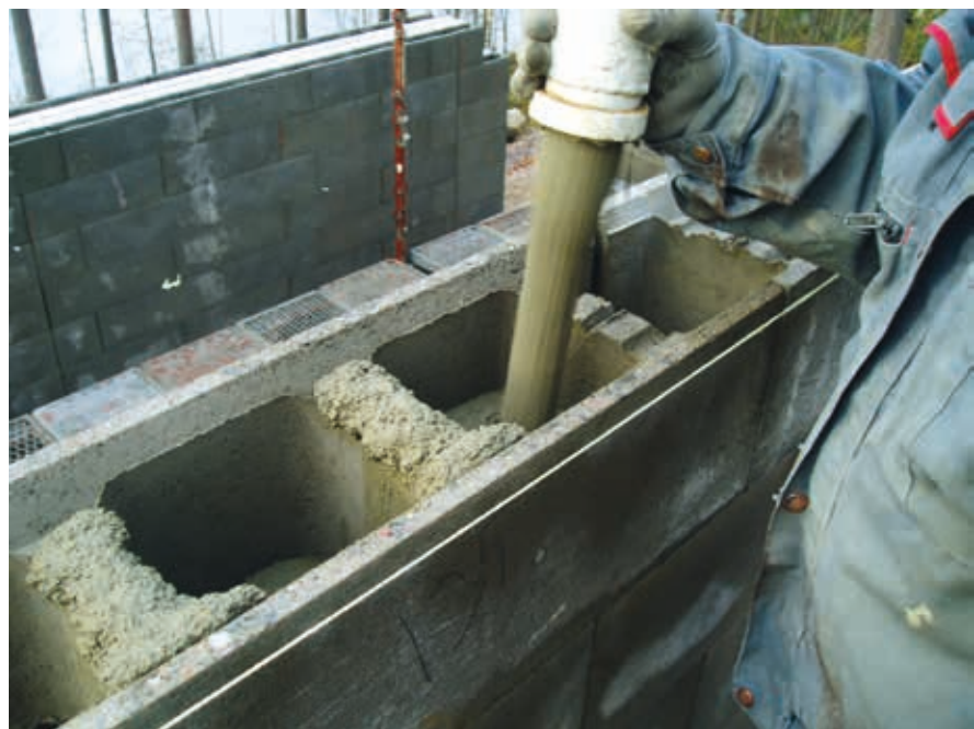
Ladontatyön jälkeen seinä valetaan pumppubetonointina. Betonin laatu määritellään rakennussuunnitelmassa.
