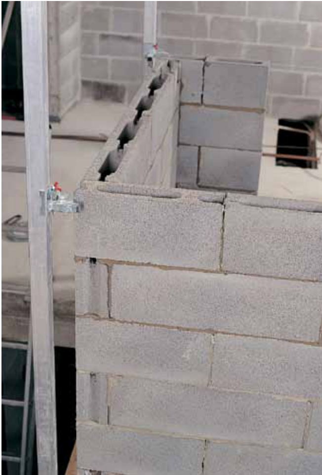
Несущая стена изготавливается полной заливкой бетоном. Углы, дверные косяки и места крепления встроенной мебели также можно усилить бетонной заливкой.
